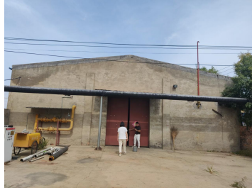
八里庄供热站
