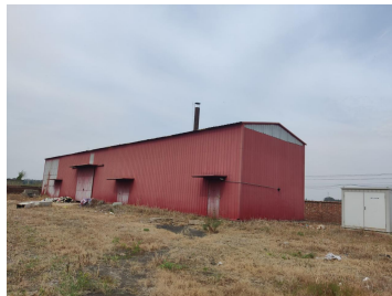
杨家园供热站
